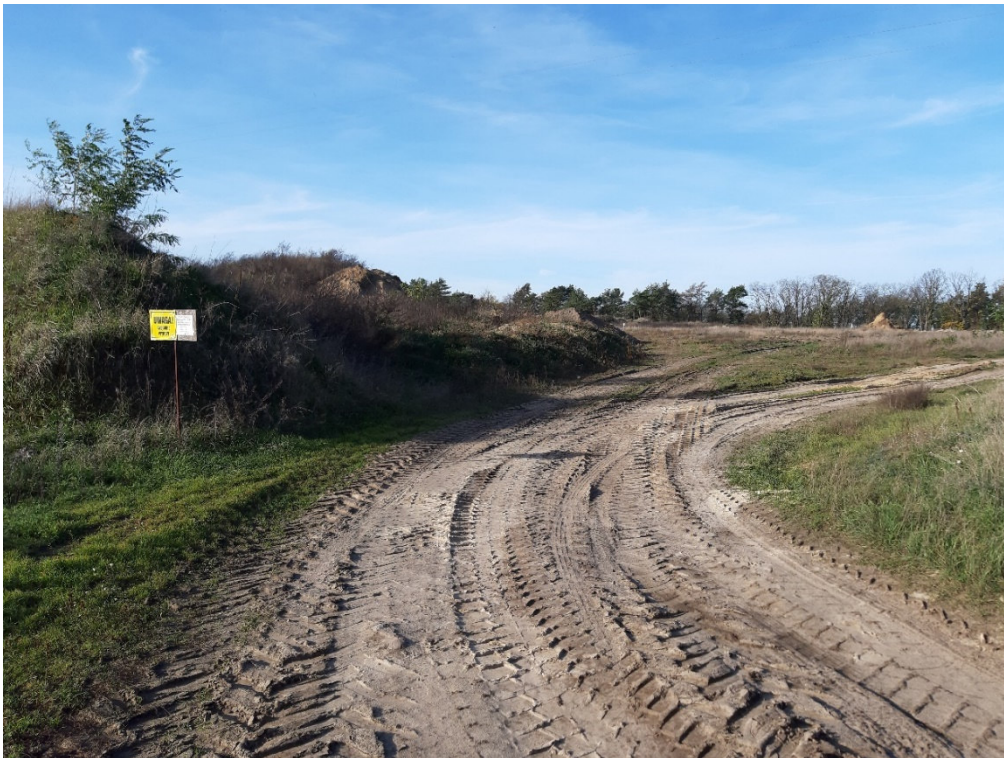
Ryc. 5. Teren objęty planem – widok z drogi wewnętrznej
