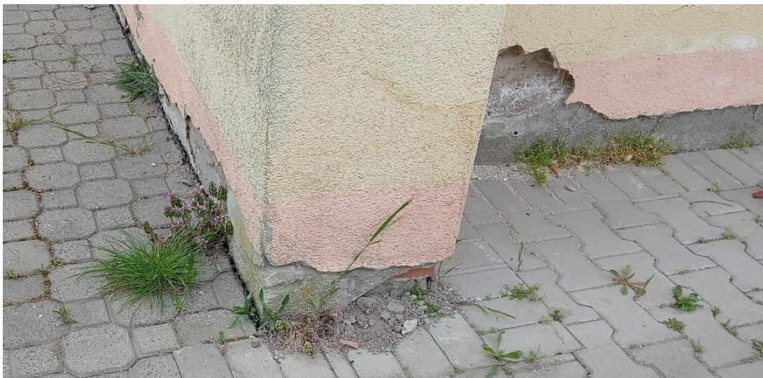
Ryc. 19 Budynek OSP w Mochach
