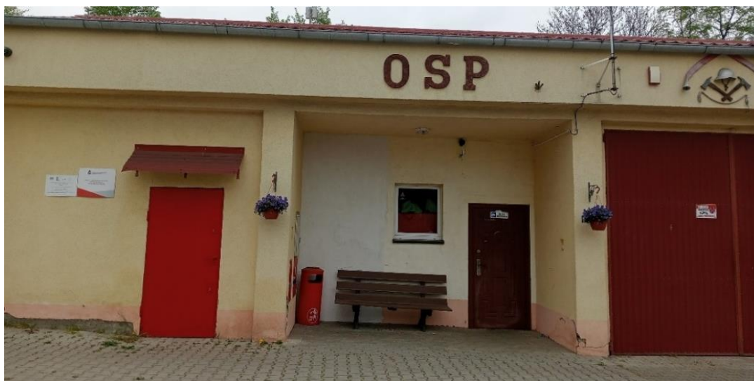
Ryc. 18 Budynek OSP w Mochach
