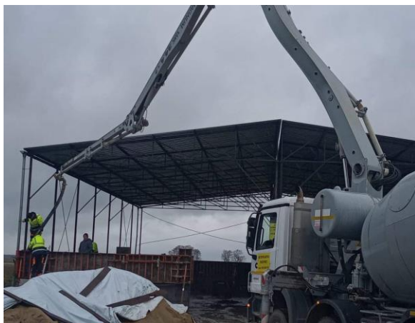
Rozbudowa komory magazynu osadu
