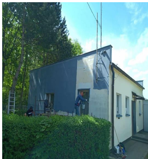
Remont budynku technicznego na terenie oczyszczalni w Wieleniu
